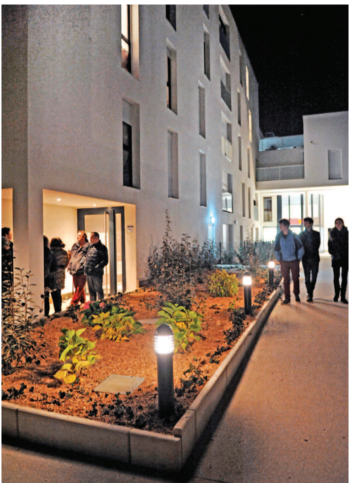
La résidence fraîchement livrée du 38, rue de la Fédération comprend 15 logements sociaux.
