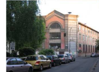
Etablissement Chapal, rue Kléber protégé PLU
