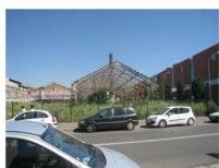
Rue de Paris Halle Eiffel et cheminée, non protégée
