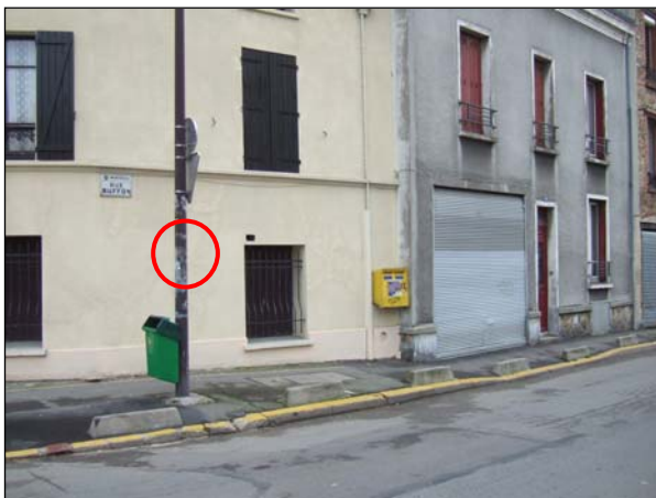
Site n°2 - Rue Buffon au niveau du n°30, axe encaissé de 2x1 voie
