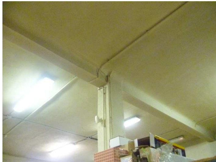
Plancher haut RDC repris par poutre béton
