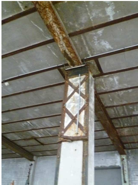
Renforcement tête de poteaux pour carrière métallique
