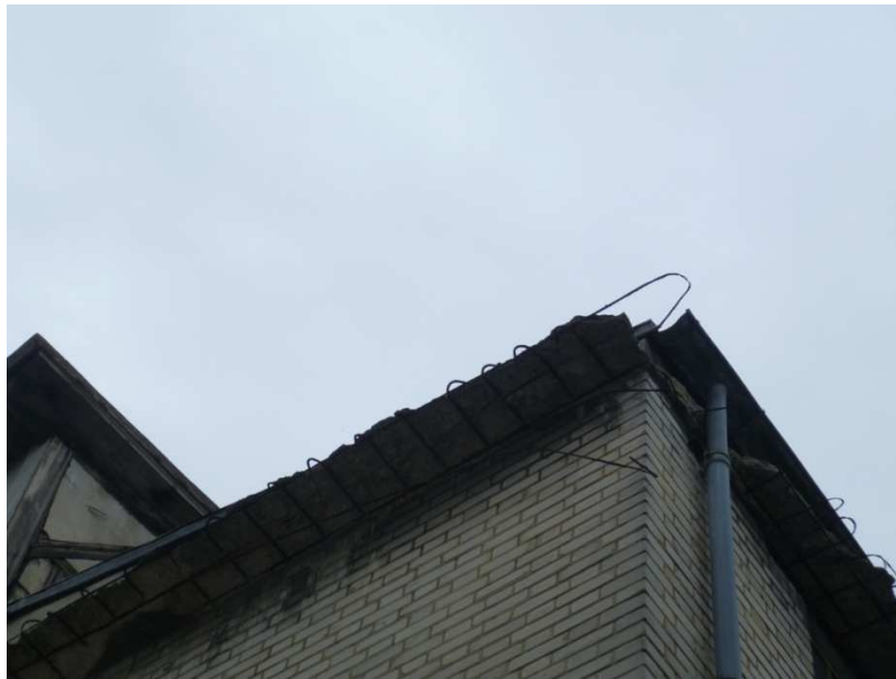
Présence d'attente acier sur pignon A3 côté rue (en partie haute)
