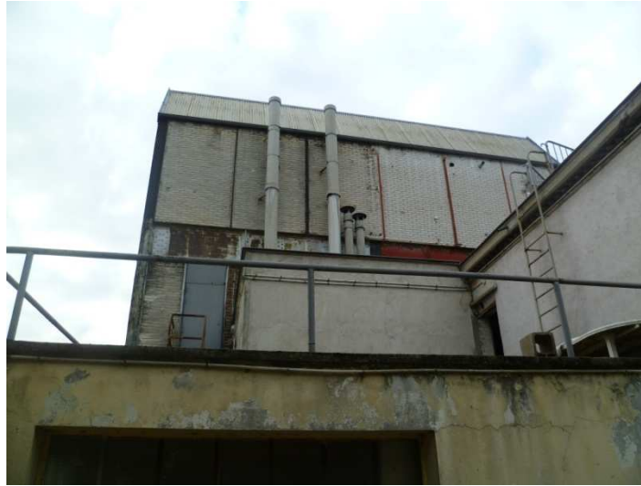
Vue cheminée pignon A2 (présence de conduits en amiante ciment)
