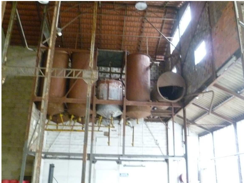
Cuves de l'exploitation antérieures – Elargissement par auvent latéral
