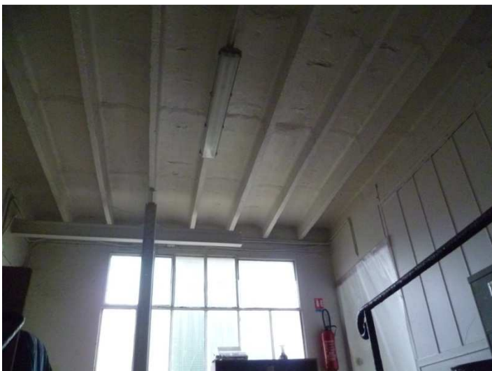
Poutre sous terrasse
