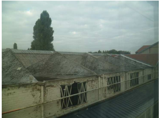
Coques béton partie centrale
