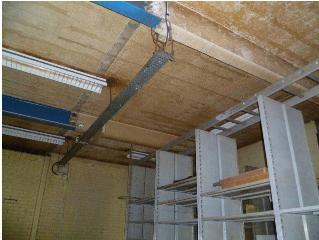
Habillage béton sur poutrelle métal coté pignon Nord 1er étage A2
