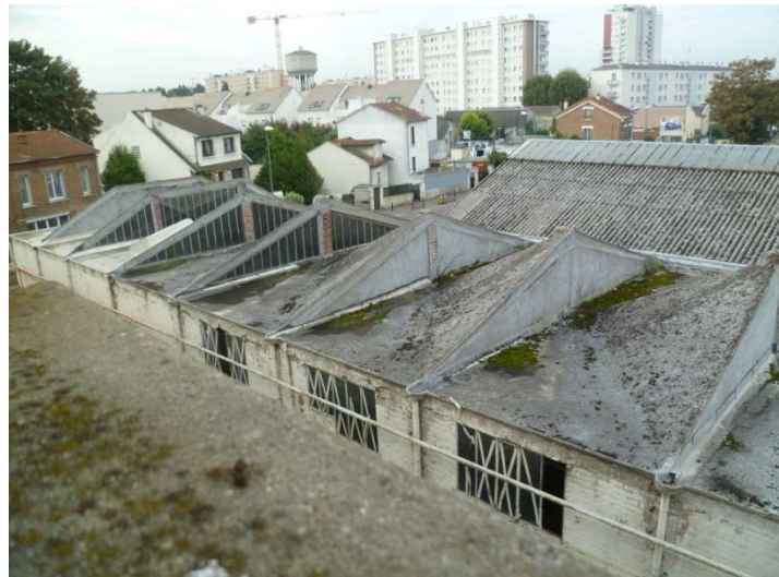
Tympan des coques rebouché.
