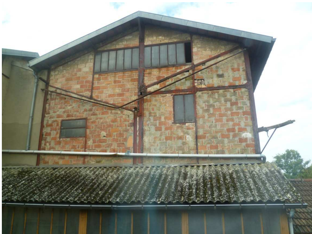
Au premier plan, couverture auvent en tôle « ETERNIT »
