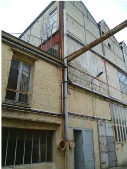
Liaison bâtiment A1 – A2 sur circulation centrale
