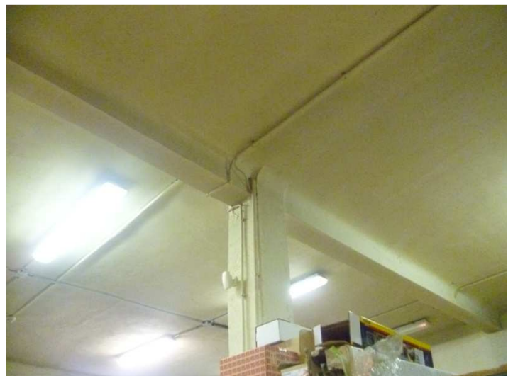
Plancher haut RDC, poutre et poteau
