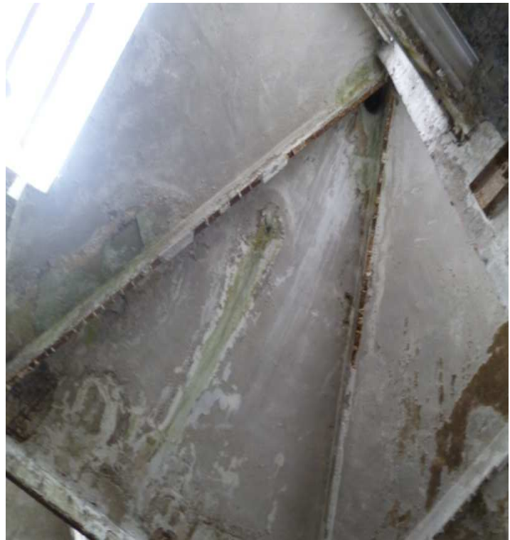
Poutres en sous face dégradée au niveau de l'enrobage acier
