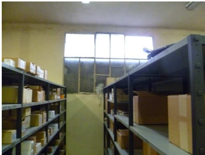
Châssis métallique façade Est rue
