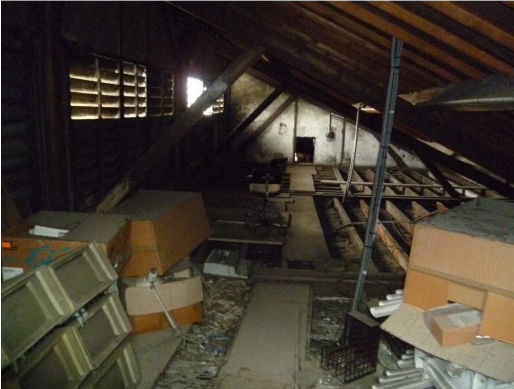
Vue sur grenier A3 et A4
