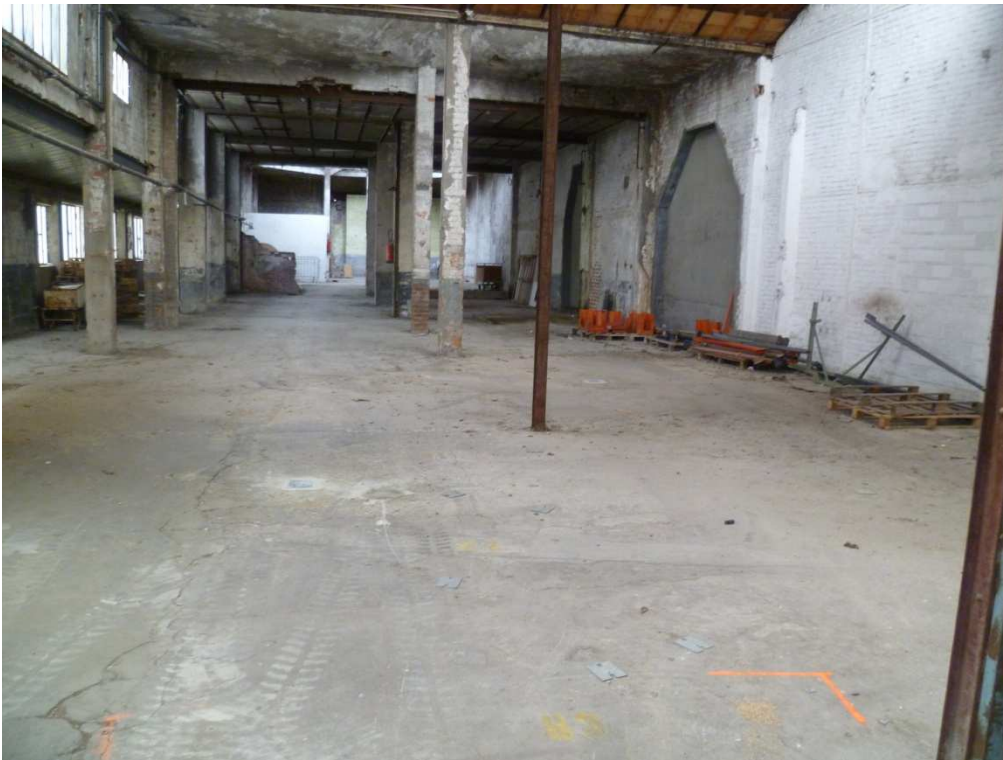
Vue générale côté Sud
