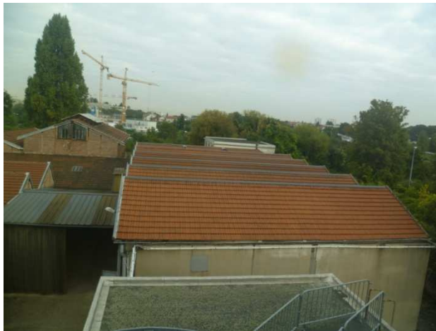
Shed de couverture tuile
