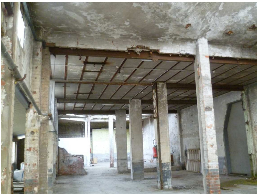
Sous plancher en poutrelle métallique et hourdis sur IPN en renforcement de poutre (sur 3 trames zone centrale)
