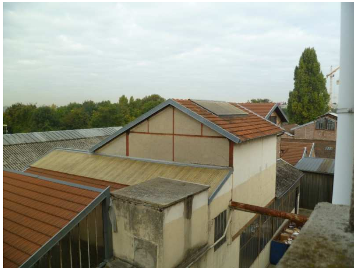
Au premier plan, édicule qui monte en toiture. Le toit double pente : zone E3
