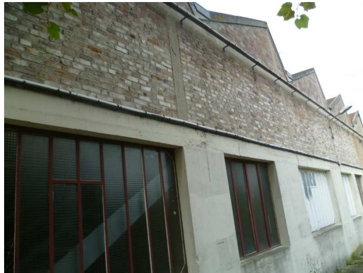
Façade latérale Est
