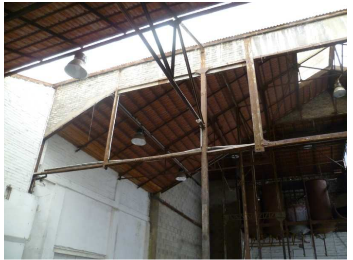
Poutraison centrale : entrain non continu en poutre basse
