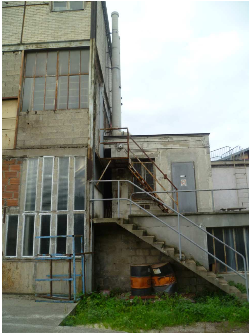
Vue liaison façade Est bâtiments A2 et A1
