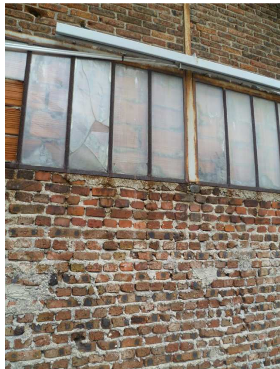
Les montants des « pans de fer » ne descendent pas jusqu'aux fondations Mauvaise stabilité de la maçonnerie (un seul rang de brique)
