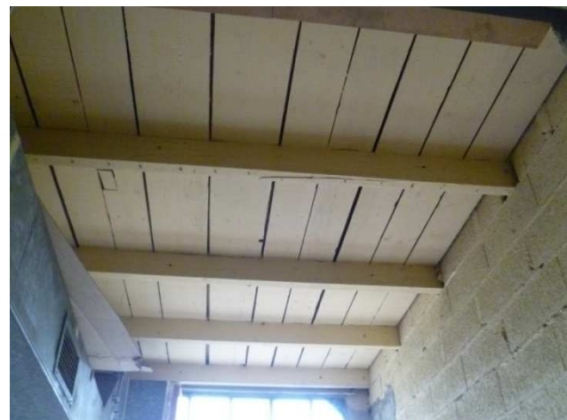
Plancher haut RDC partiel en bois
