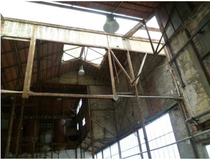
Poutraison centrale : entrain non continu en poutre basse
