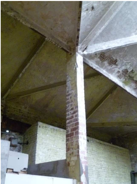
Poutres en sous face dégradée au niveau de l'enrobage acier
