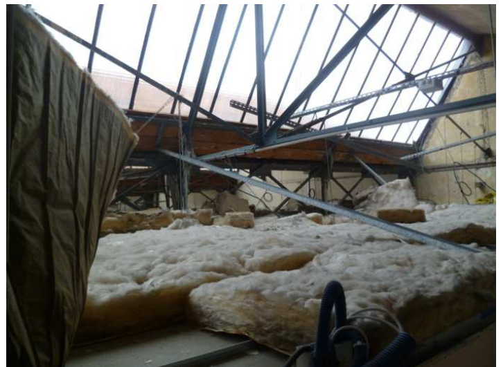
Vue sur shed isolation sur plafond 2ème étage A2
