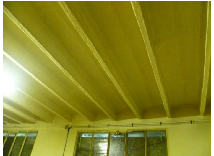
Poutrelle apparente en garage
