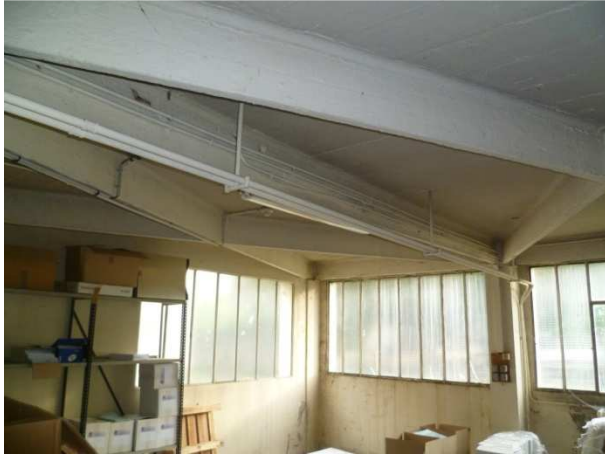
Vue intérieure RDC poutraison béton en "Diagonale"
