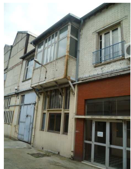
Entrée sur bureaux bâtiment A3 Bow Windows au 1er étage
