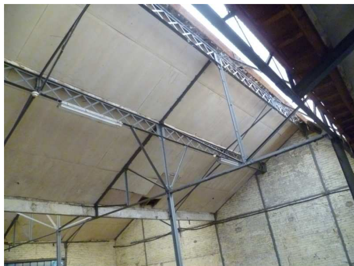
Vue sur structure acier
