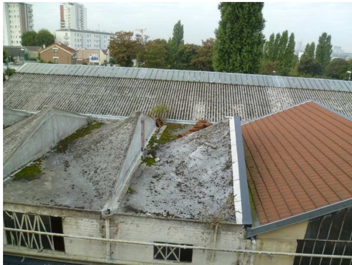
Liaison shed / coques béton présence de végétation, au deuxième plan couverture amiante du bâtiment F (ex VALDA) avec faitage vitré central
