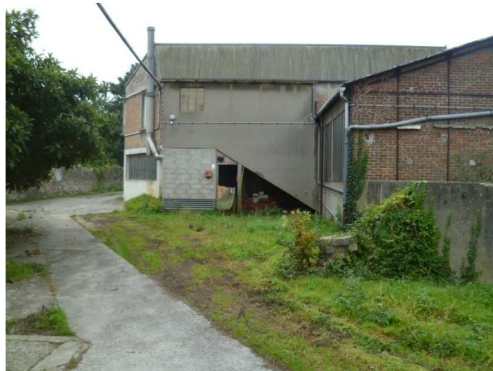
Pignon Nord bâtiments B et C
