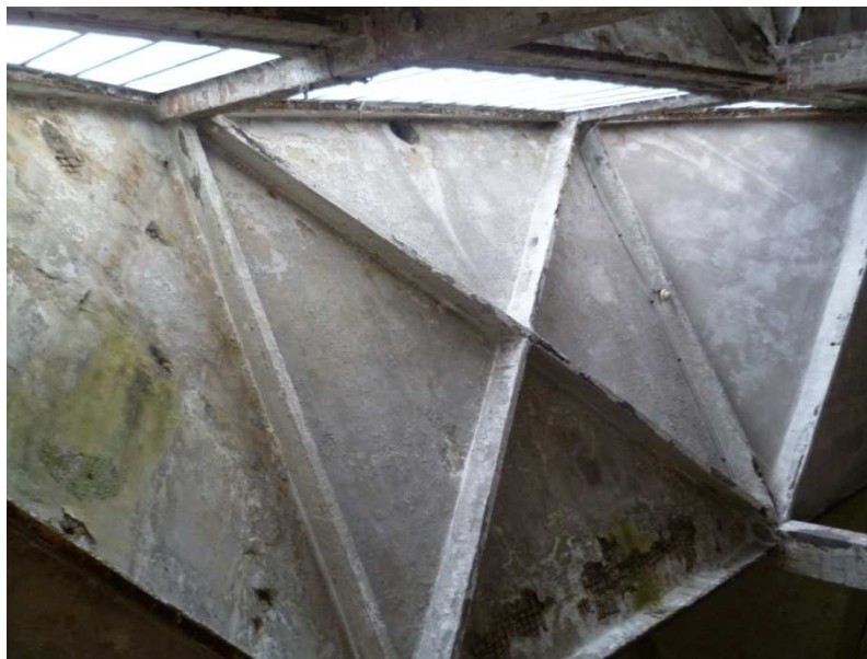
Vue sous face coque béton côté rue avec poutraison
