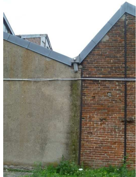
Vue latérale – Absence de descente pluviale sur le shed de gauche
