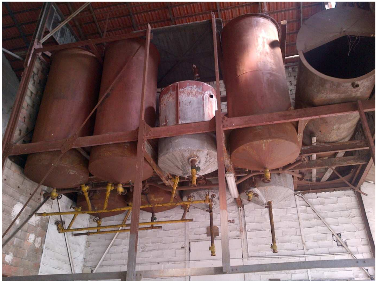
Zone Nord bâtiment E cuves de l'ancienne exploitation
