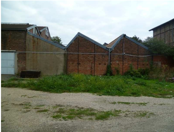
Vue latérale – Absence de descente pluviale sur le shed de gauche
