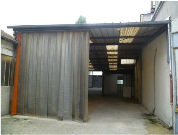
Fermeture en façade par porte lanière plastique de type LANATEC.
