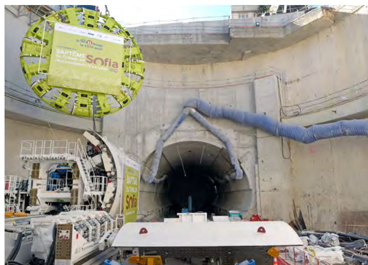
La foreuse de 100 m de long creuse et bâtit le tunnel de la ligne 11.
