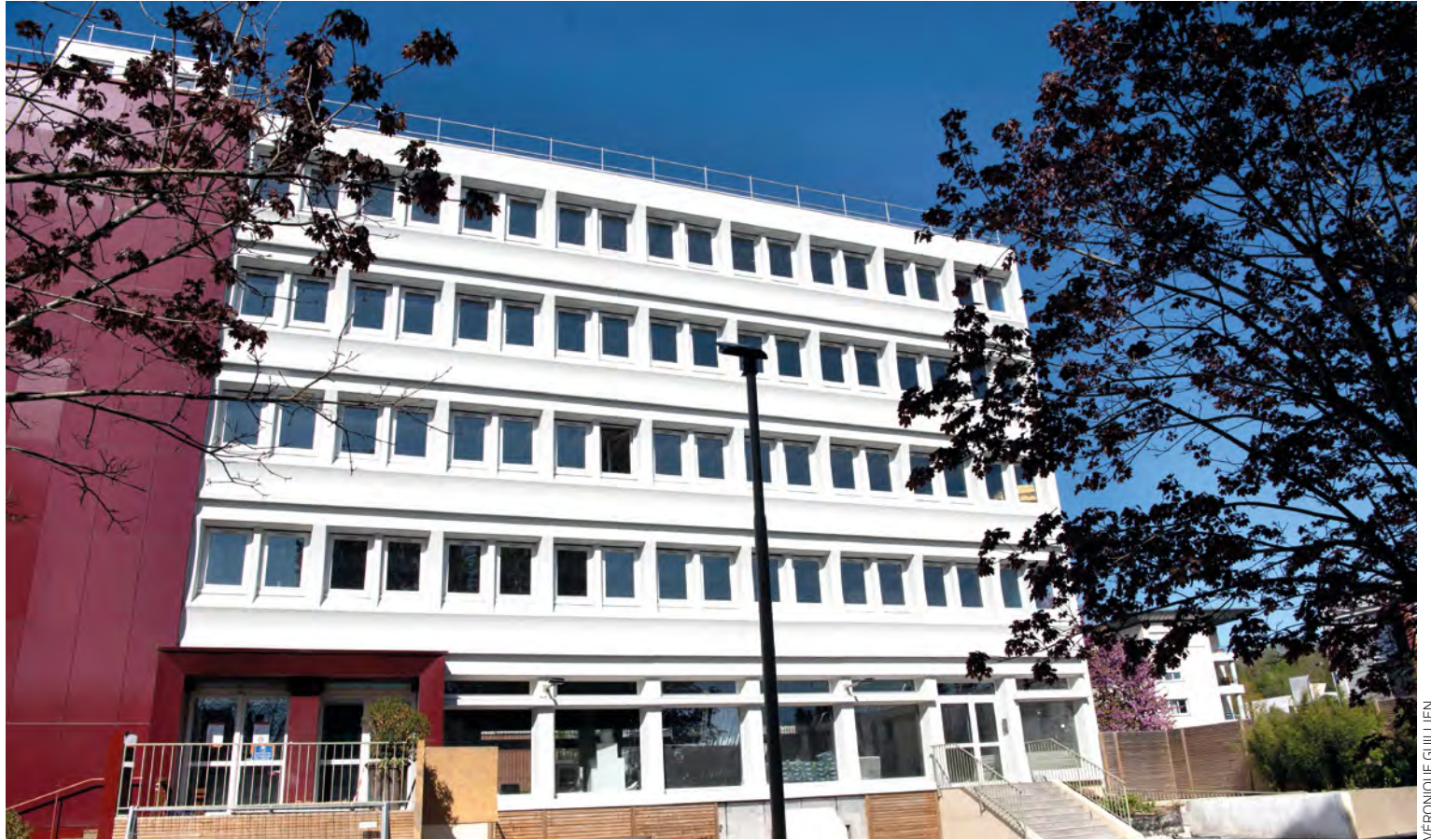
Au 63, rue Gaston-Lauriau, dans les locaux de Cap Horn, il y aura prochainement une maison de santé regroupant de nombreuses spécialités.
