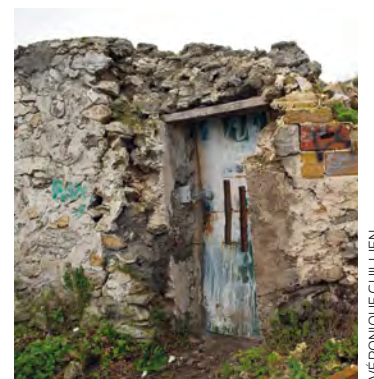
LES MURS À PÊCHES, RUE DE LA NOUVELLE-FRANCE. J'aime me balader à vélo dans ce coin de Montreuil.
