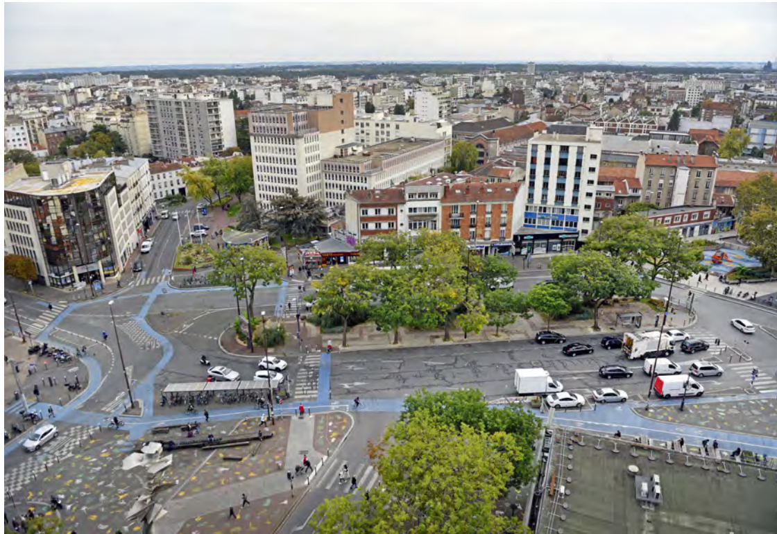
Vue panoramique de la place Jacques-Duclos, qui accueille les nouveaux aménagements.
