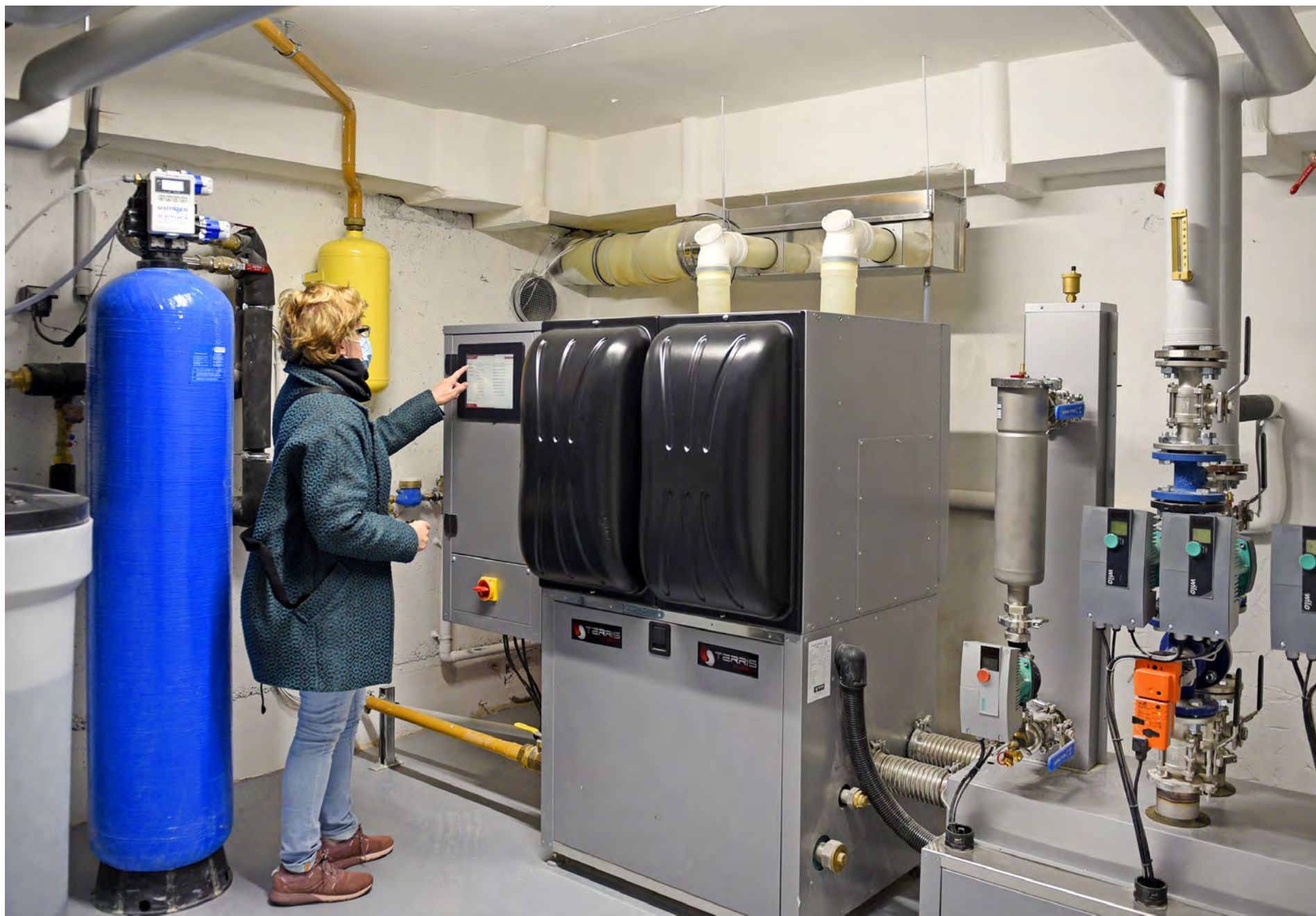
La résidence Caract'ère, au 41, boulevard Paul-Vaillant-Couturier, présente la particularité de disposer d'une chaudière à gaz pilotée à distance informatiquement.
