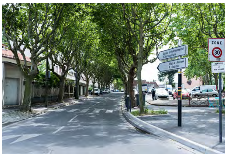
La rue Paul-Doumer avant que ne débutent les travaux.
