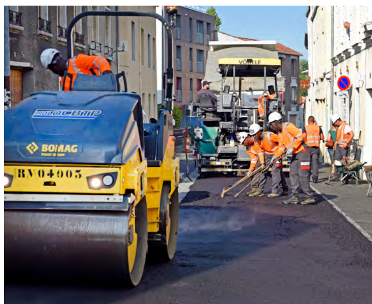
La deuxième phase des travaux prendra fin courant septembre.
