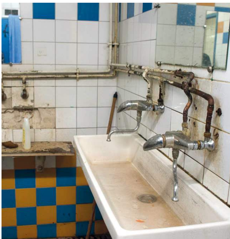
Canalisations, robinetterie et murs sont en très mauvais état.
