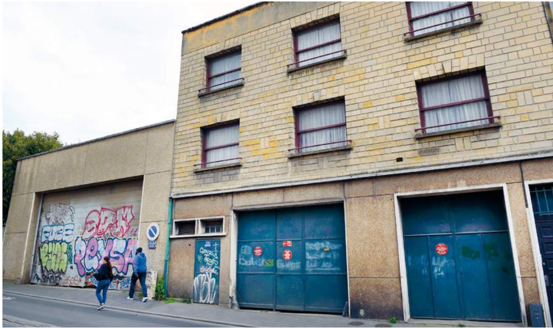
La façade historique de l'ancien site industriel Berthollet, rue Étienne-Marcel.
