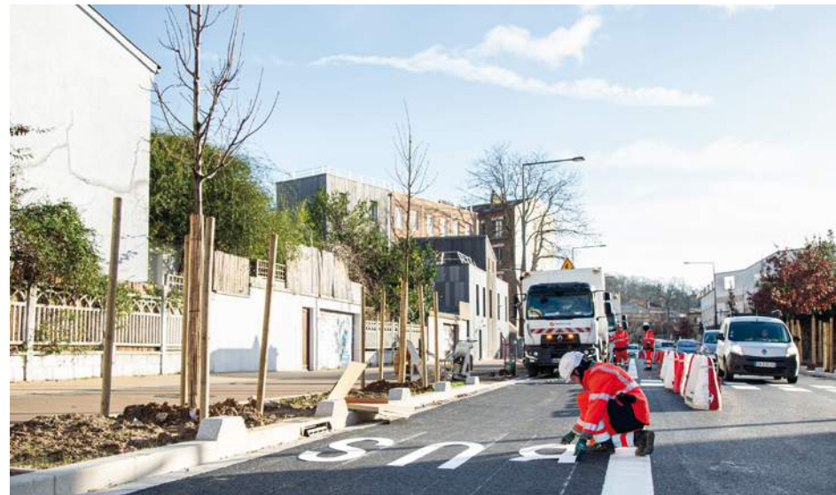
Après la plantation des arbres dans l'avenue, les ouvriers dessinent la signalétique.
