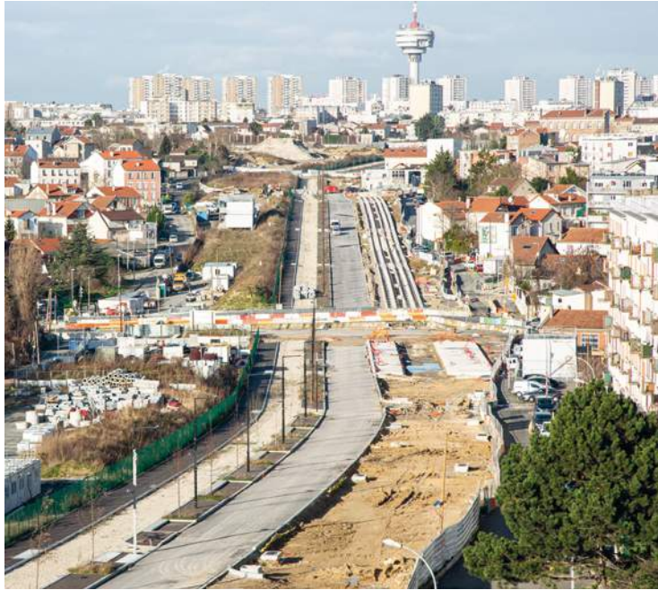
Vue des travaux du tramway T1 sur l'ancien parcours de l'A186.
