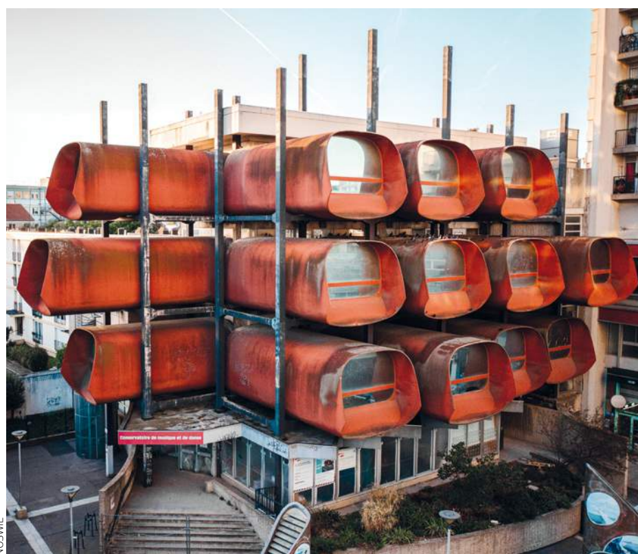
Le conservatoire avant le début des travaux de rénovation.
